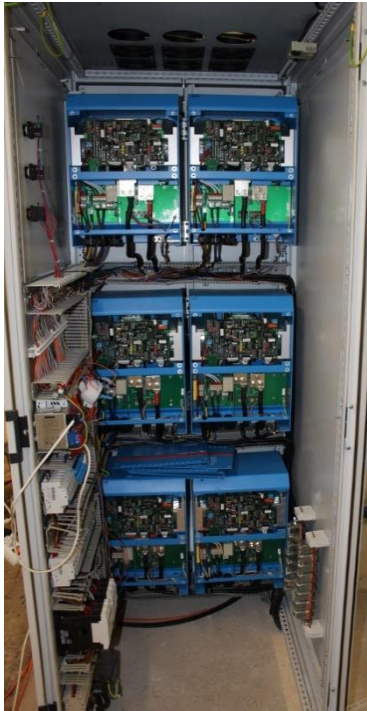
Leistungs- und Steuerungsschrank
