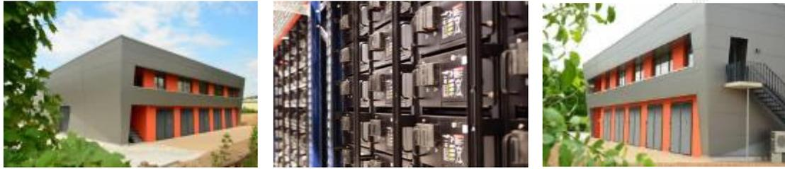
**Fotos:** Gebäudeintegrierter Batteriespeicher in Chemnitz (Links/Rechts: Außenaufnahme; Mitte: Innenaufnahme der Samsung Li-Ion Speichereinheiten)
