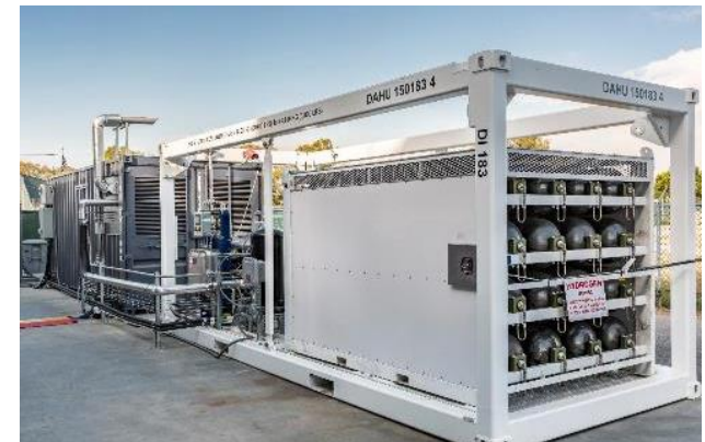
200 kW SOEC module in Los Angeles, USA
