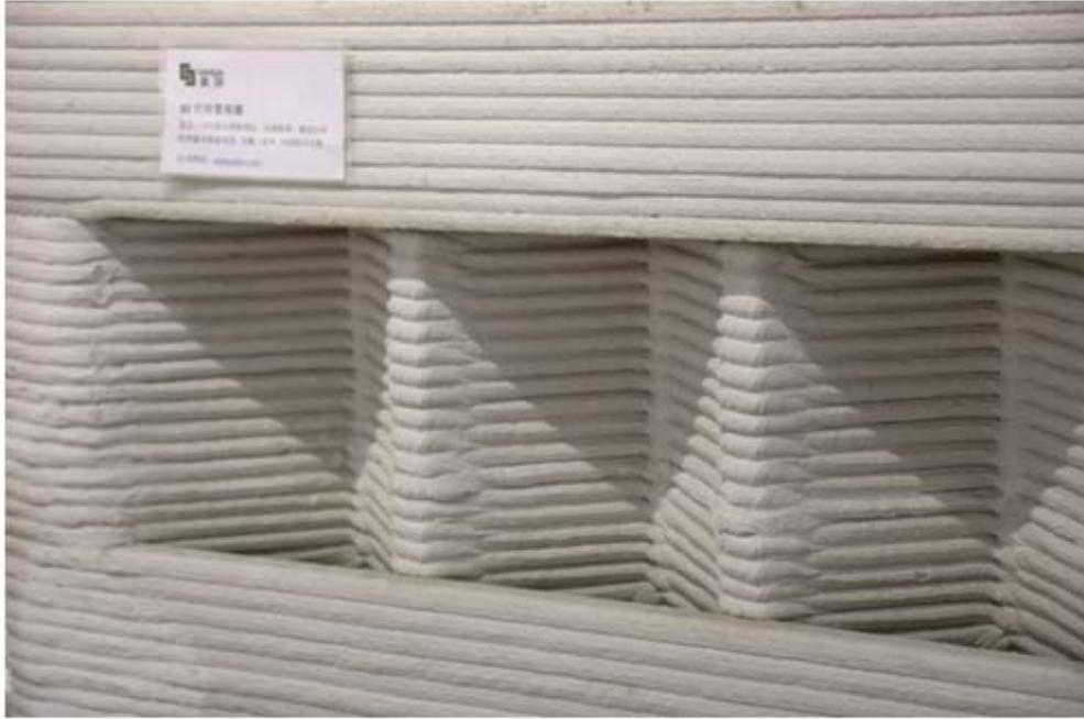
↗ Gedruckte einzelne Schichten werden zur tragfähigen Wand
