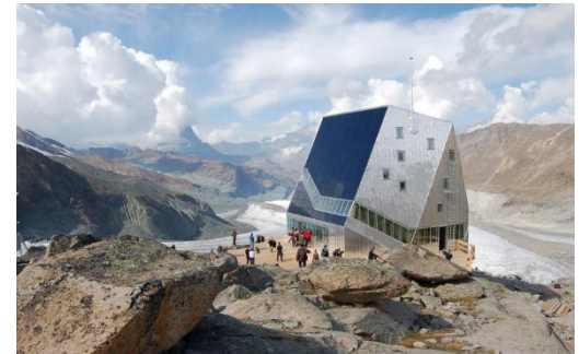
Neue Monte Rosa Hütte (Zermatt, CH): Energieautarke Bergunterkunft mit konzeptionellem Ansatz „Gebäude als System“. Rolle Hochschule Luzern: Energiekonzept, Begleitung Umsetzung, Energie-Monitoring.
