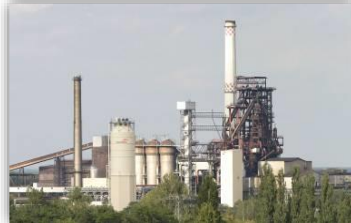
Roheisenwerk: Reduktion Fe-Oxid mit C
